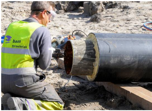
Afb. 2 en 3. Aardwarmte Den Haag legt leidingen en kabels tussen de aardwarmtebron en de -centrale.
