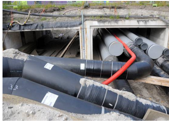
Afb. 2 en 3. Aardwarmte Den Haag legt leidingen en kabels tussen de aardwarmtebron en de -centrale.
