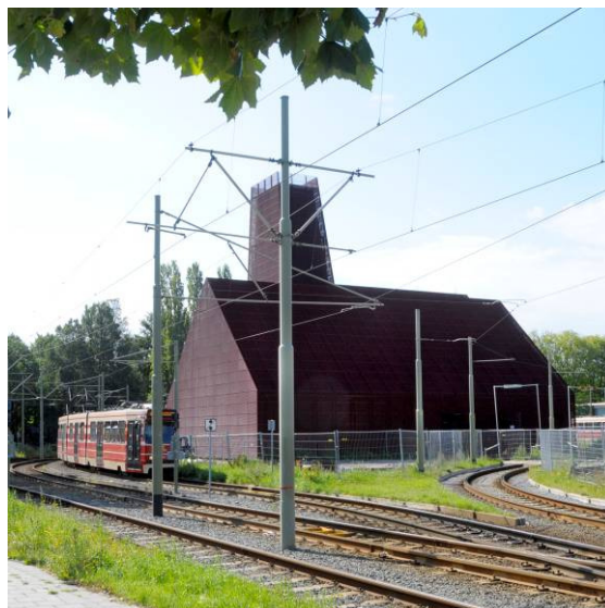
Afb. 4. Nadat het aardwarmtesysteem in bedrijf is, wordt de ruimte rondom de aardwarmtecentrale ingericht.
