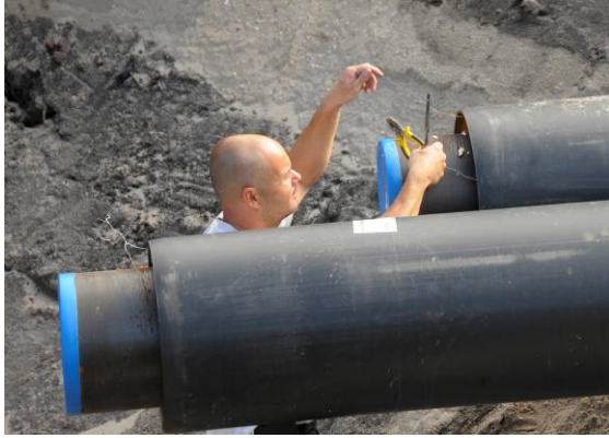
Afb. 2. De leidingaanleg tussen de aardwarmtebron en de aardwarmtecentrale wordt voortgezet.
