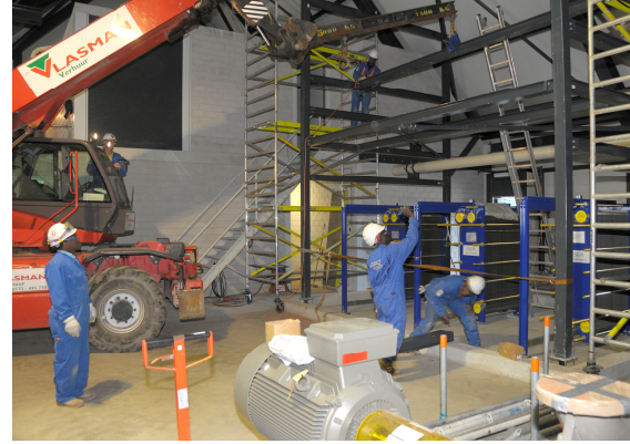
Afb. 3. De aannemer installeert technische installaties in de aardwarmtecentrale.
