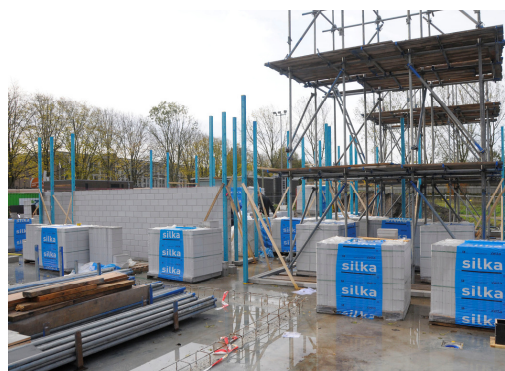
Afbeelding 1. Werkzaamheden aardwarmtecentrale, 3 november 2010
