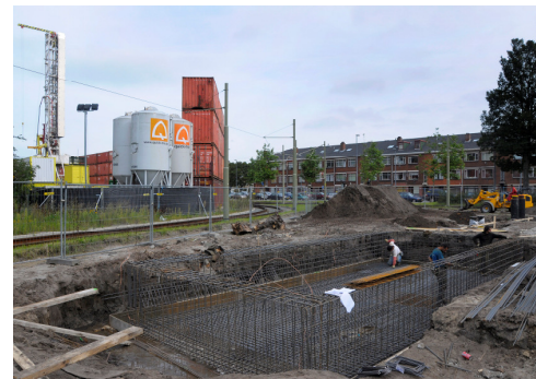
Afbeelding 3. Wapening ondervloer aardwarmtecentrale
